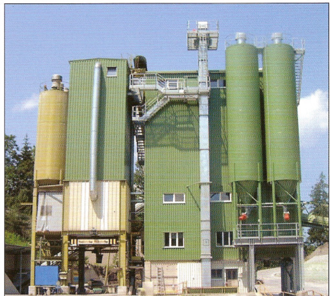
Seit Ende Mai gewährleistet die neue Betonanlage der Frischbeton Thun AG in Wimmis BE die Betonversorgung im Raum Spiez, Kander- und Niderrsimmental. Fotos: zVg
