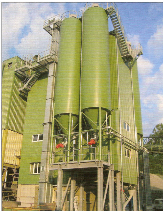
Die neuen Produktionsinstallationen wurden teilweise auf bestehenden Fundamenten und Stahlkonstruktionen errichtet
