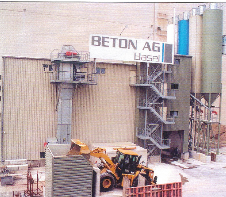
Im Hafenbecken II in Basel Kleinhüningen hat das erste Betonwerk der Stadt Basel seine Produktion aufgenommen. Im Bild zu sehen ist die Doubrava-Kompaktanlage 400 der Beton AG Basel mit dem Aufgabebunker für Schiffsentladung
